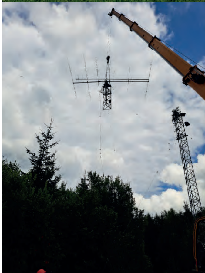
Antennerna på plats, under rotorn sitter våra 16 stycken "fasta" 3-elementsantennor för 144 MHz.
