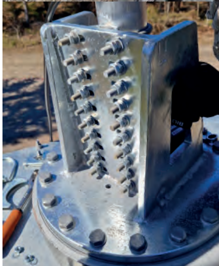
Från vänster topp: Svängkranslager monterat, vinkelhylla (tillfälligt i aluminium), vänster botten: Rätt vinkelhylla i stål, Svängkranslagret i sitt normala användningsområde.
