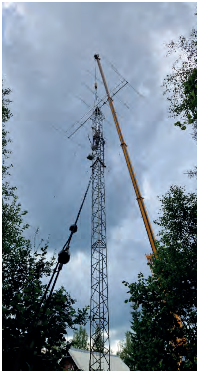
Toppsektionen med antenner lyfts på plats och monteras fast i masten.
