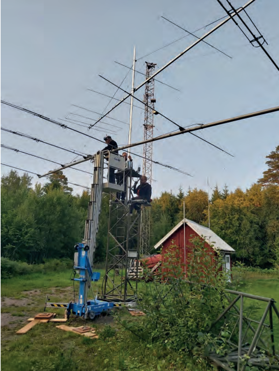
KT34XA och 50 MHz LFA2-HD Yagin monteras ihop och båda antennerna monteras i den tillfälliga toppsektionen.
